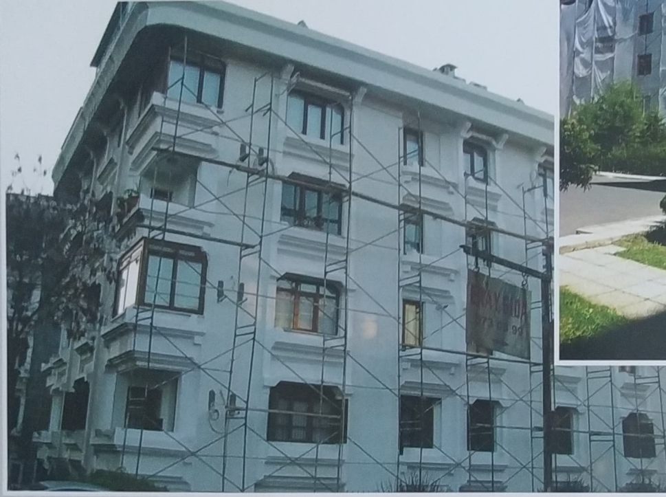
Yeşilköy Altuğ ve Reşatbey Apartmanı Dış Cephe Mantolama ve Boya Yapılması - 3600 m 2 Yeşilköy - Bakırköy
