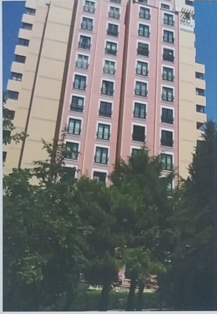
Bahçeşehir Funda 01 05 D8 Blok Dış Cephe Onarım ve Boya Yapılması 10500 m 2 Bahçeşehir - Başakşehir
