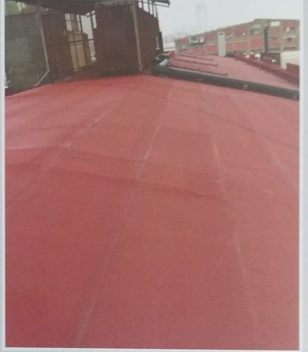
Mir Holding Dizayn Grup Kıraç Fabrika Çatısı Su İzolasyonu İşİ 2750 m 2 Kıraç / Hadimköy
