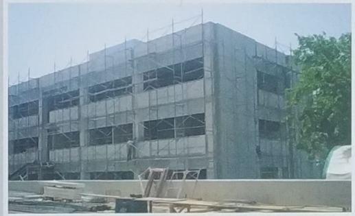
ABB Elektrik A.Ş. İdari Binası Komple İçce İşlerin Yapılması Kartal - İstanbul
