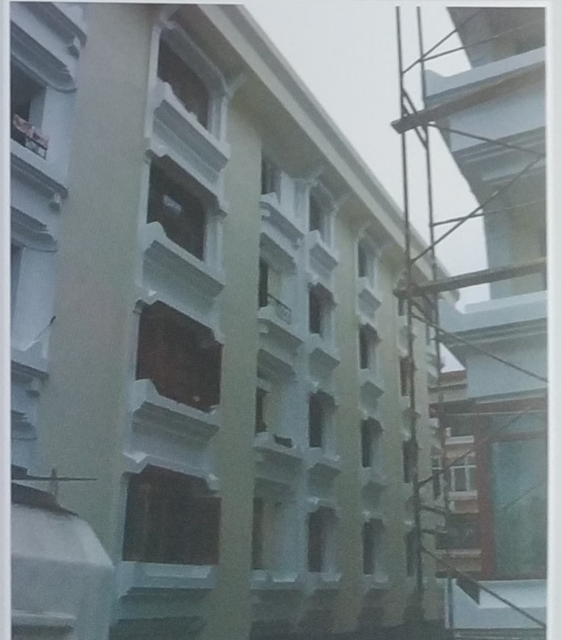
Yeşilköy Altuğ ve Reşatbey Apartmanı Dış Cephe Mantolama ve Boya Yapılması - 3600 m 2 Yeşilköy - Bakırköy
