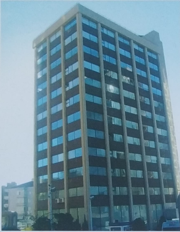
Anadolu Hayat Sigorta Binası Dış Cephe Onarım ve Boya, İç Cephe Boya İşlerinin Yapılması 4500 m 2 Gayrettepe - İstanbul
