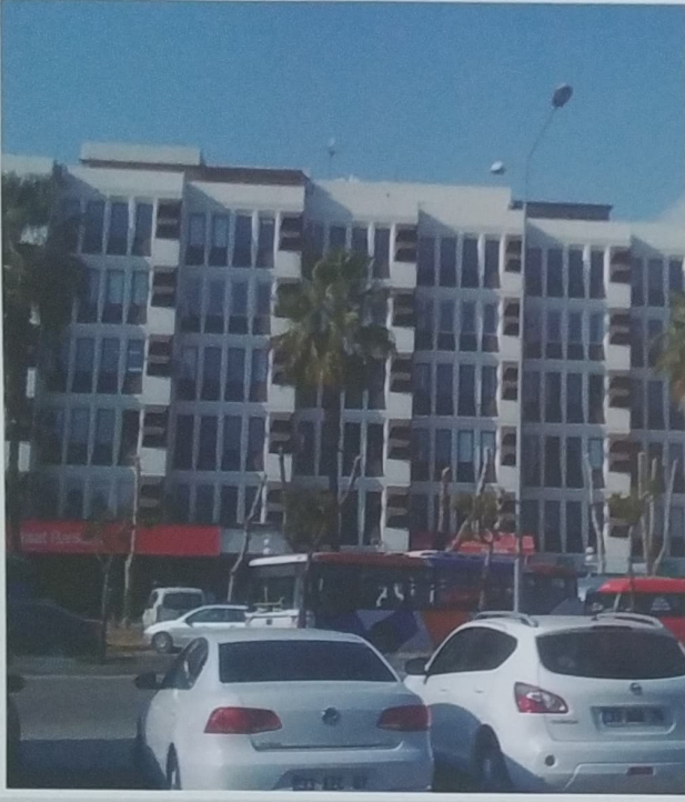
Anadolu Hayat Emeklilik Binası Dış Cephe Onarım, Boya, İç Cephe, Alçı Sıva ve Boya İşİ Yapılması 6500 m 2 Mersin / Merkez
