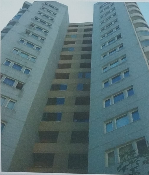
Beylikdüzü Beykent Mavikent C6 Blok Dış Cephe Onarım ve Boya Yapılması İşİ 11.000 m 2 Beylikdüzü - İstanbul
