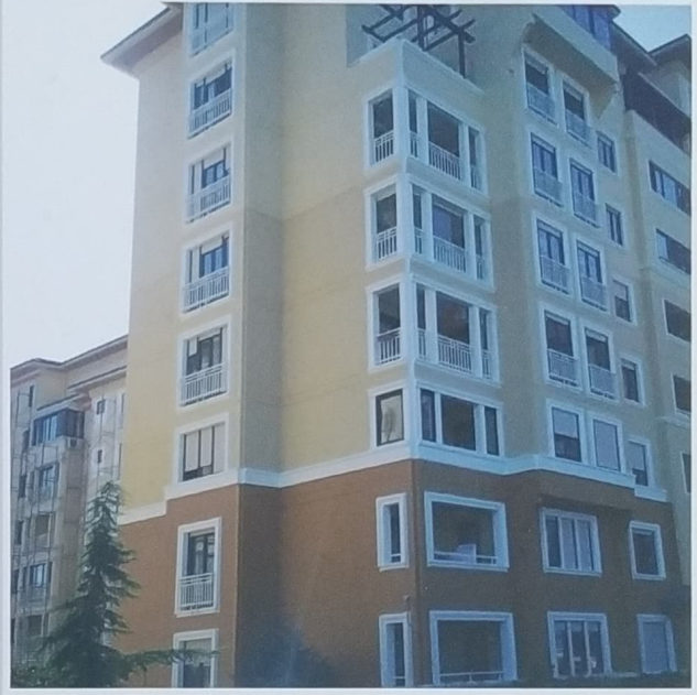
Bahçeşehir Ilgaz 3 Blokları Dış Cephe Onarım ve Boya Yapılması - 13.500 m 2 Bahçeşehir - Başakşehir
