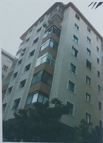
Aslan Apt. Dış Cephe Mantolama ve Söve Uygulaması - 2500 m 2 Göztepe - Kadıköy
