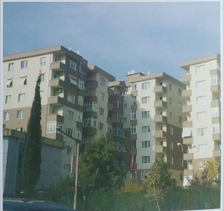
Göztepe Boğaziçi Sitesi Dış Cephe Mantolama Yapılması - 36000 m 2 Göztepe - Kadıköy
